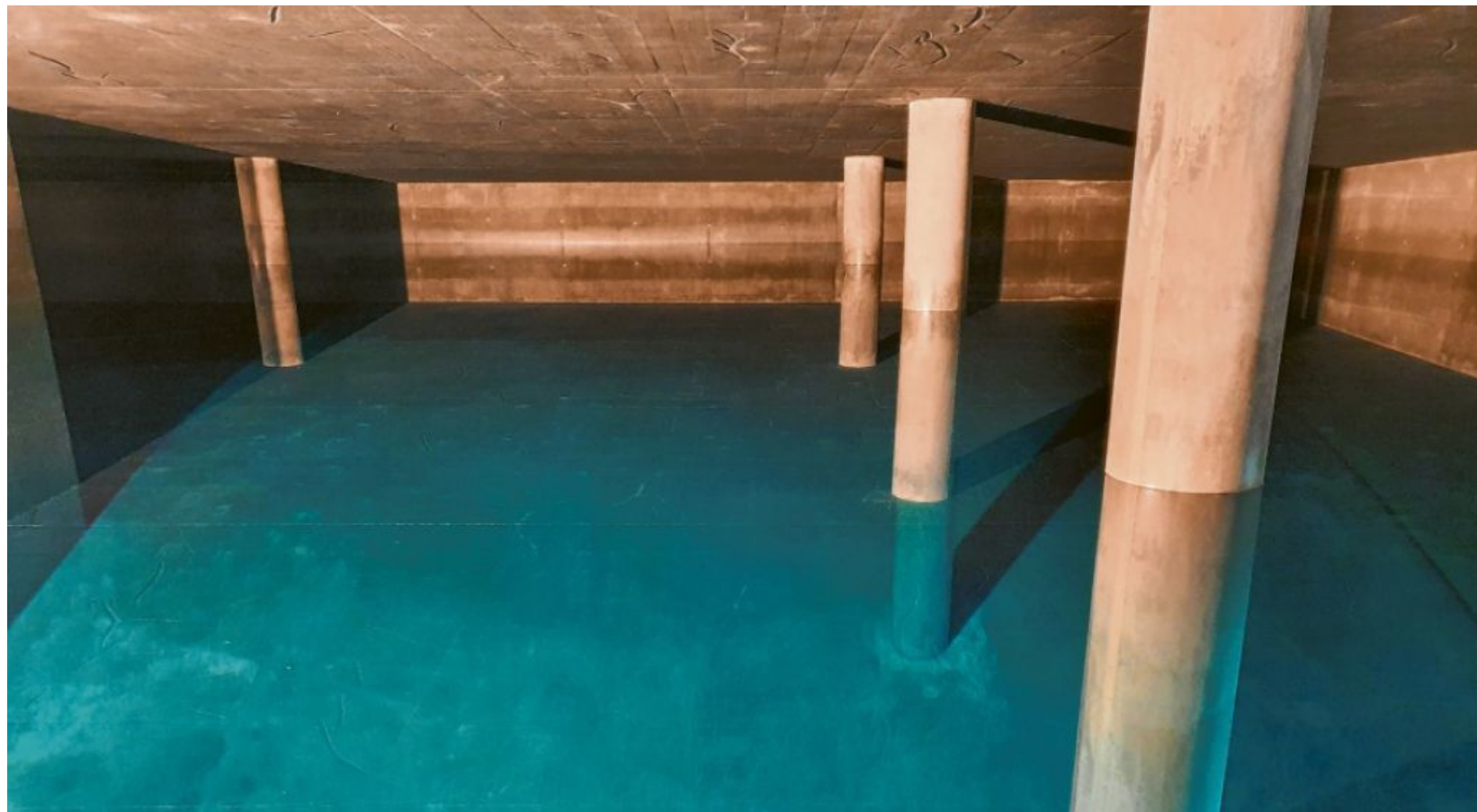
Einer der beiden sechs Meter tiefen Rechteckbehälter. 27 Monate hat der Bau des Hochbehälters der Bayerischen Rieswasserversorgung gedauert. Er soll sicherstellen, dass im Ries zu jeder Zeit genug Trinkwasser zur Verfügung steht.
